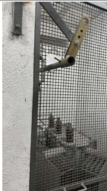
18. CHAVE DE ABERTURA DO TRANSFORMADOR
