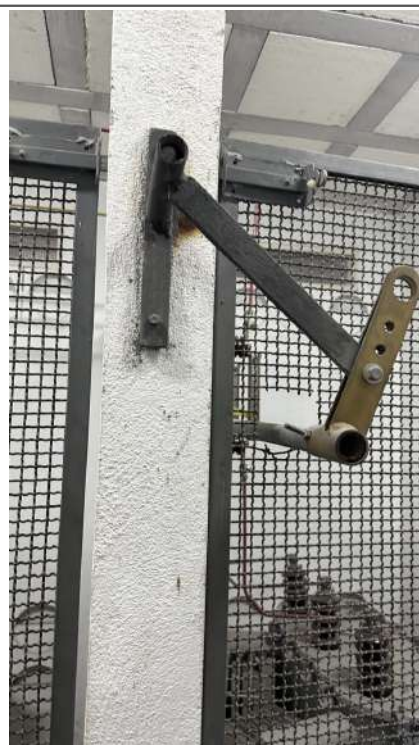
20. BLOQUEIO DA CHAVE SECCIONADORA
