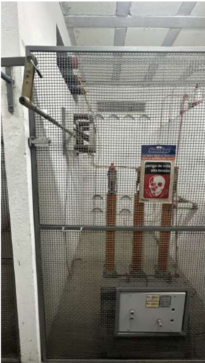
10. CUBÍCULO DE DISJUNÇÃO
