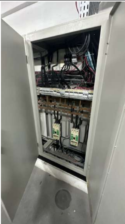
23. BARRAMENTOS DO QUADRO GERAL DE BAIXA TENSÃO
