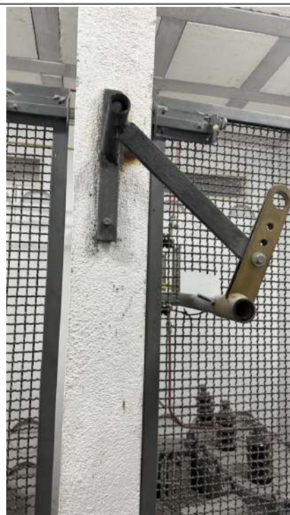
20. BLOQUEIO DA CHAVE SECCIONADORA
