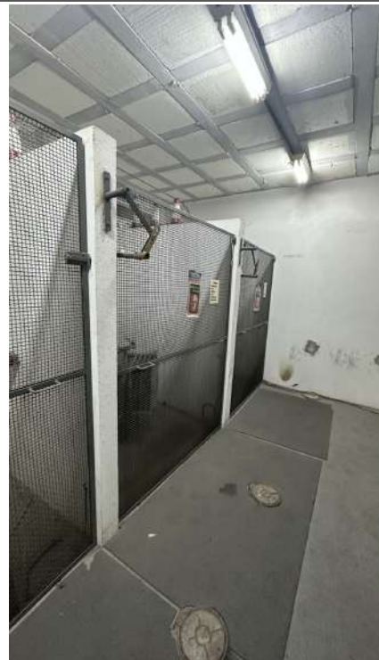
16. CÚBICULO DE TRANSFORMAÇÃO - 2 TRANSFORMADORES DE 300 KVA
