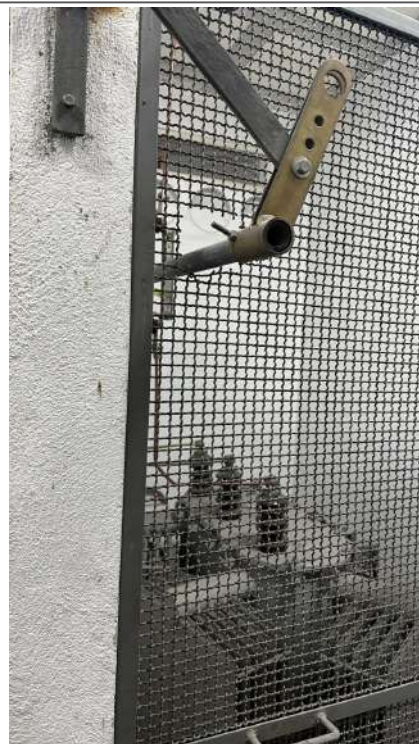
18. CHAVE DE ABERTURA DO TRANSFORMADOR
