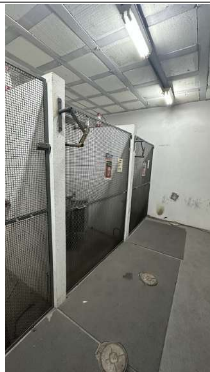
16. CÚBICULO DE TRANSFORMAÇÃO - 2 TRANSFORMADORES DE 300 KVA
