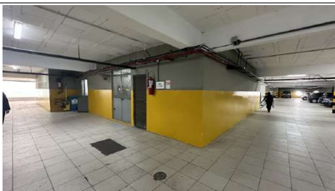
Foto 7(Vista do portão de acesso a subestação)
