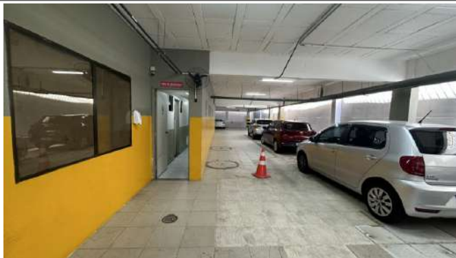
Foto 5(Via de acesso a subestação pelo subsolo)
