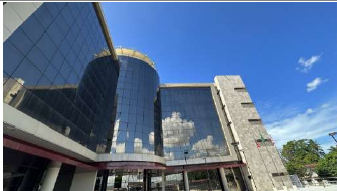
Foto 1(Fachada Frontal do prédio)
