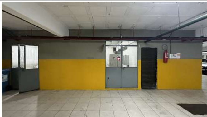
Foto 9(Vista do portão de acesso a subestação)
