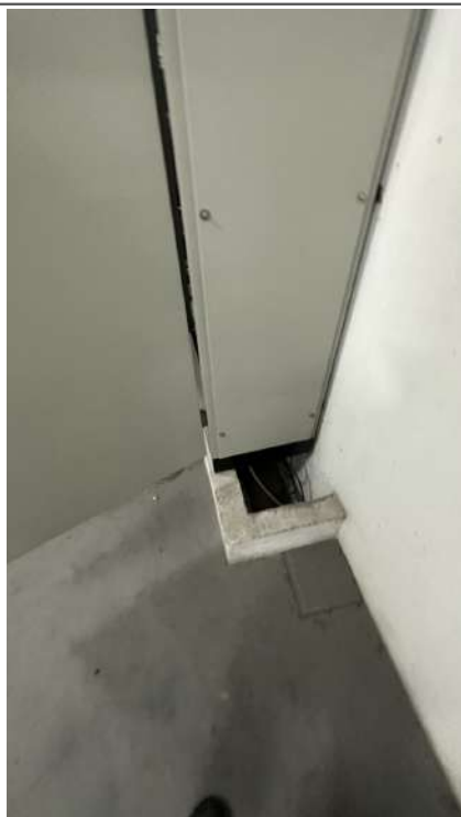
27. VALA DE ACESSO AO QGBT
