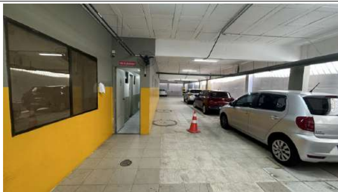
Foto 5(Via de acesso a subestação pelo subsolo)
