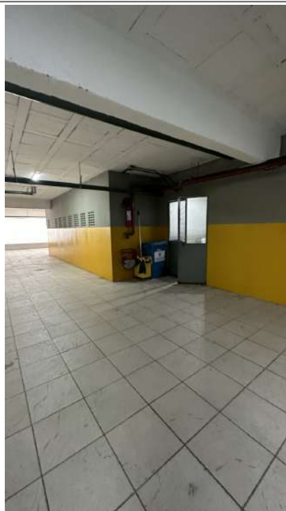
Foto 10(Vista do portão de acesso ao depósito na lateral da subestação)
