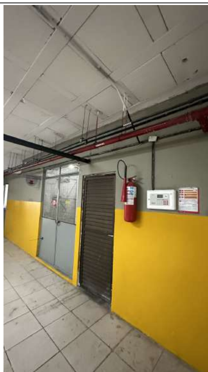
Foto 8(Vista do portão de acesso a subestação)
