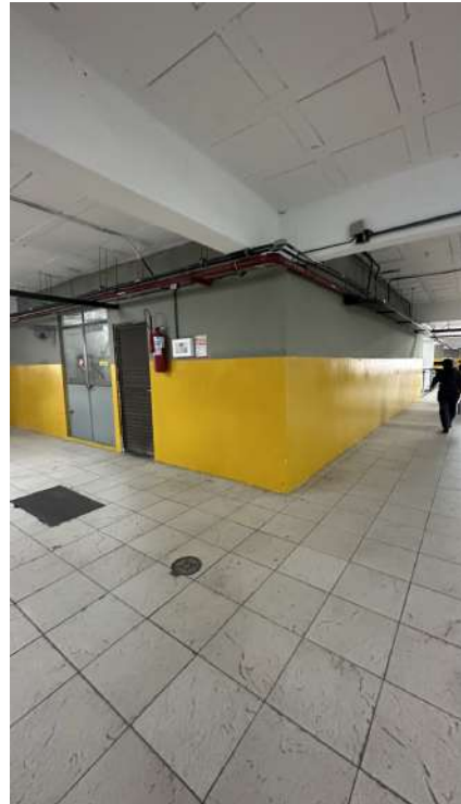
Foto 4(Via de acesso a subestação pelo subsolo)
