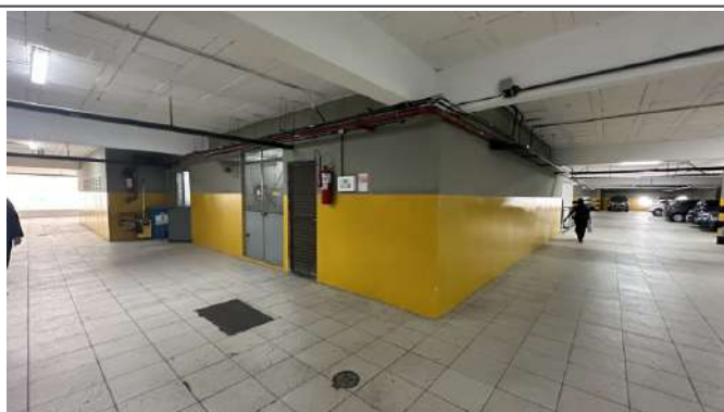
Foto 7(Vista do portão de acesso a subestação)
