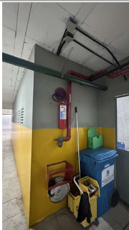
30. ALTURA DOS ELETRODUTOS EXISTENTES
