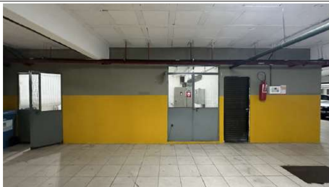
Foto 9(Vista do portão de acesso a subestação)
