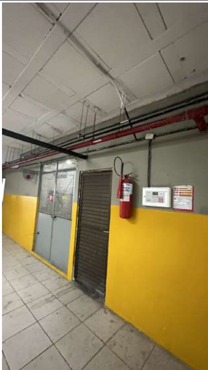
5. TUBULAÇÃO EXISTENTE NA ENTRADA DA SUBESTAÇÃO E NO LIMITE DA VIGA
