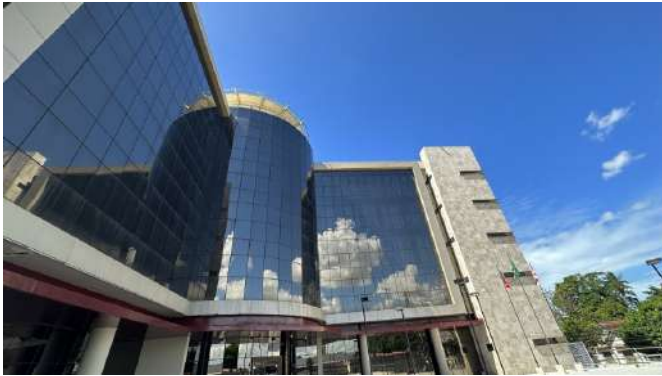
Foto 1(Fachada Frontal do prédio)
